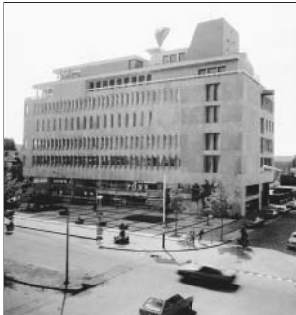
Knooppunt van maritieme telecommunicatie. Het gebouw van Scheveningen-Radio te IJmuiden aan de Merwedestraat.
